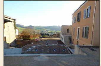
Les travaux sont en cours de finition à la Maison de santé de Matour. Photo JSL/Paul BOUILLET
